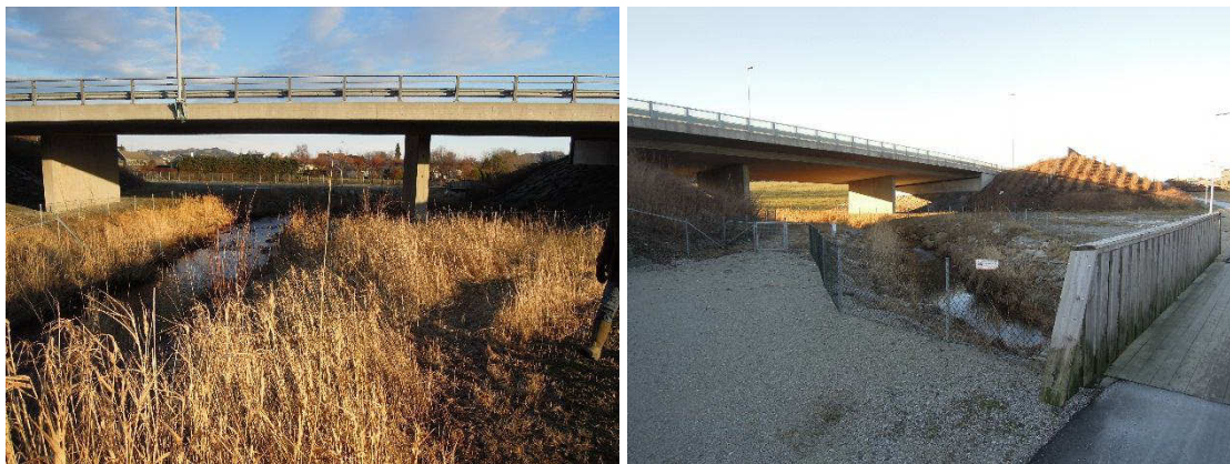
Figur 5.17. Området hvor Stangelandsåna går under RV 44 er det mye grus- og brakkmark. Bildet t.v. er tatt mot øst og bildet t.h. mot nordvest. Dette er det siste området hvor en rensepark, dam nr. 18, kan gjøre stor nytte før vannet når Gandsfjorden.
